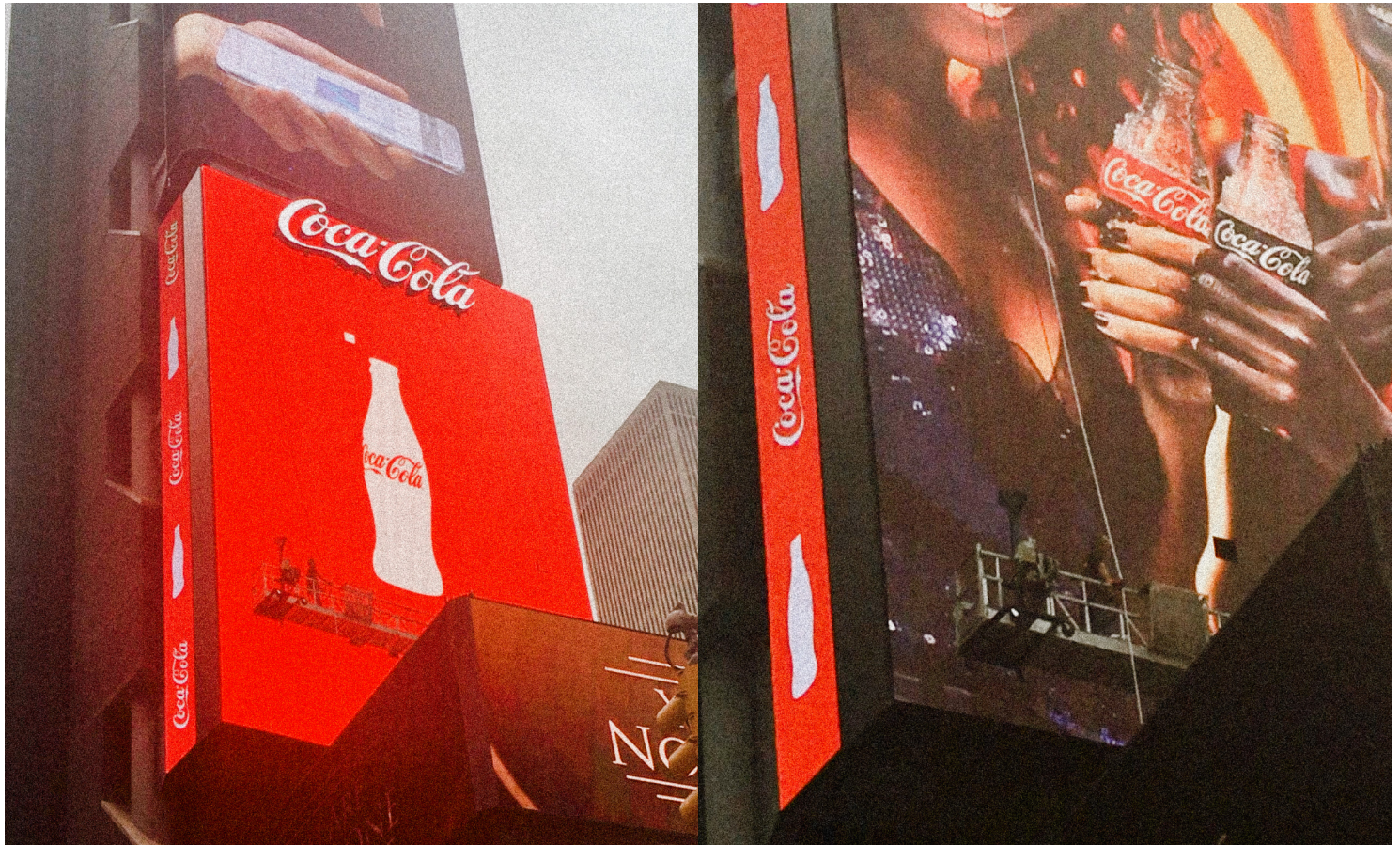
Figura 1. Dos vistas de la pantalla 3D mientras está siendo reparada en caliente.
